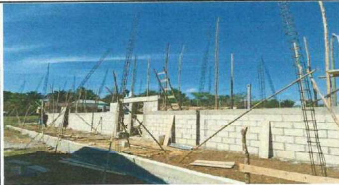
Foto 2: COLOCACION DE ESTRUCTURA DE TECHO Y CUBIERTA DE LAMINA, EN LAS AULAS NUEVAS DEL ESTABLECIMIENTO
