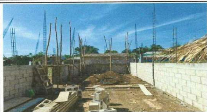
Foto 1: LOS PADRES DE FAMILIA CUBRIRAR LA FINALIZACION DE LOS MUROS Y LAS COLUMNAS QUE SE REFLEJAN EN FOTOGRAFIA
