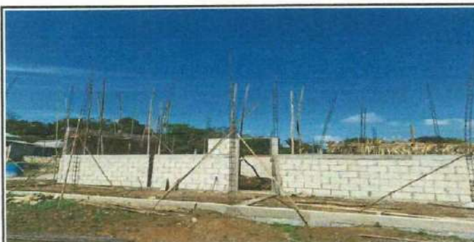
Foto 5: PROYECCION DE LAS AULAS NUEVAS PARA EL CUBRIMIENTO CON ESTRUCTURA DE TECHO Y CUBIERTA DE LAMINA
